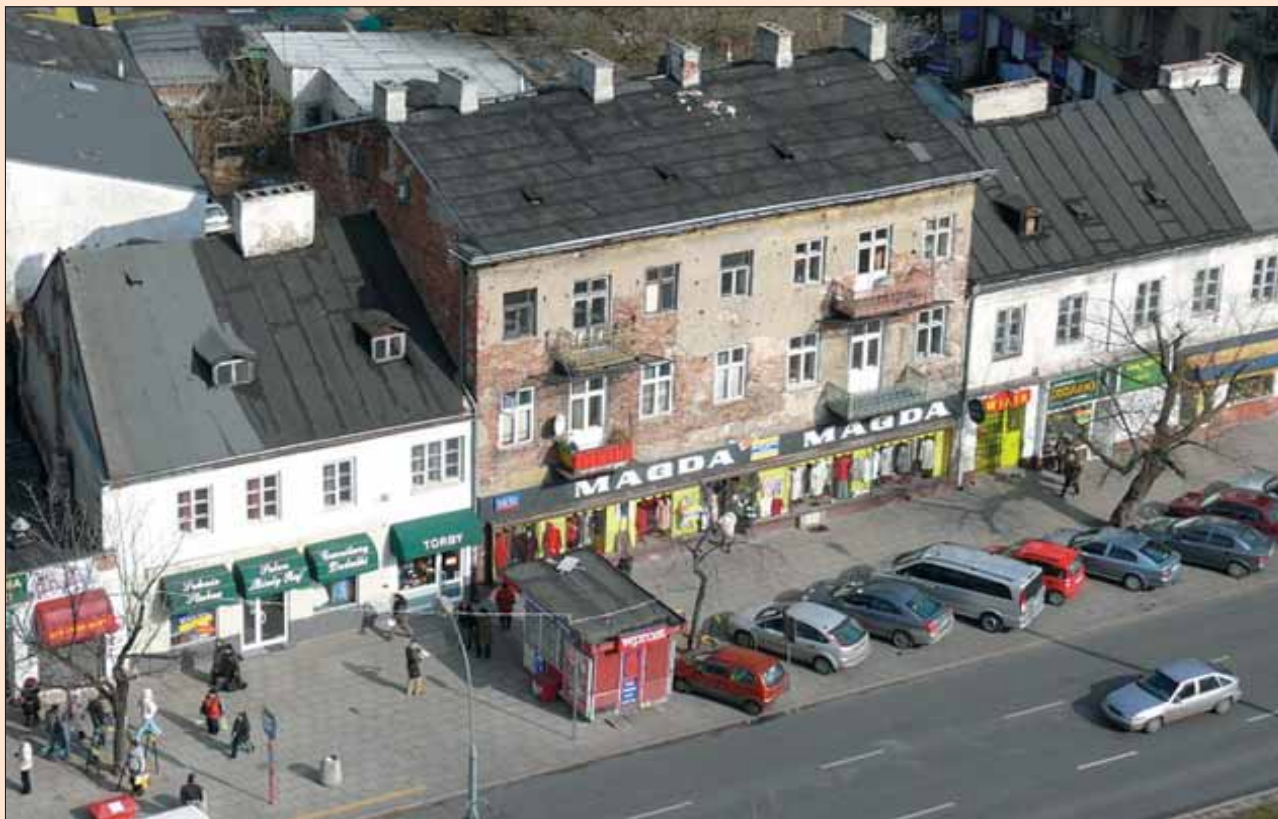
8. Targowa 50/52 – przyszła siedziba Muzeum Warszawskiej Pragi. Od lewej: kamieniczka Krzyżanowskich, kamienica Sokołowskiego oraz kamienica Rothblitha II
